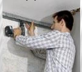
Закрепив временно направляющие профили вдоль линии разметки на полу, сделайте в нем с помощью твердосплавного сверла отверстия под дюбели.
