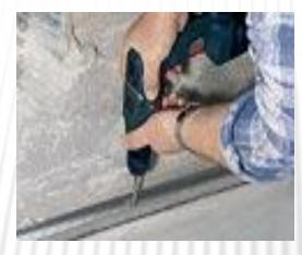
Прикрепите к полу направляющие профили с помощью дюбелей и шурупов.
