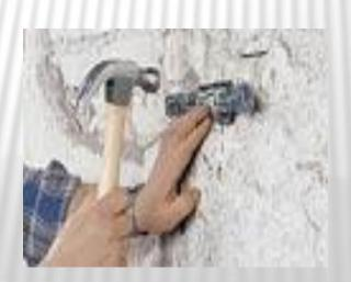
Разметьте линии расположения вертикальных стоечных профилей и места их крепления (с шагом 600 мм)
