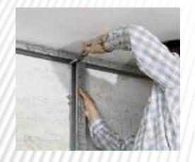
К несущей конструкции из металлических профилей прикрепите самонарезающими шурупами листы гипсокартона так, чтобы стык находился посередине "подошвы" профиля. Шаг крепления - около 250 мм.
