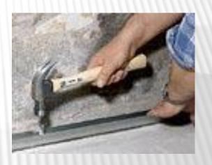
В направляющие профили на полу и потолке вставьте (поочередно) стоечные. Загните вокруг них концы прямого подвеса и, проверяя вертикальность с помощью уровня, соедините полки профиля с подвесом шурупами-саморезами. Повторите эти действия с каждым подвесом и с каждой стойкой.
